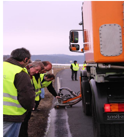
Nichts mehr zu sehen: Der Peel Jet radiert die Fahrbahnmarkierung weg
